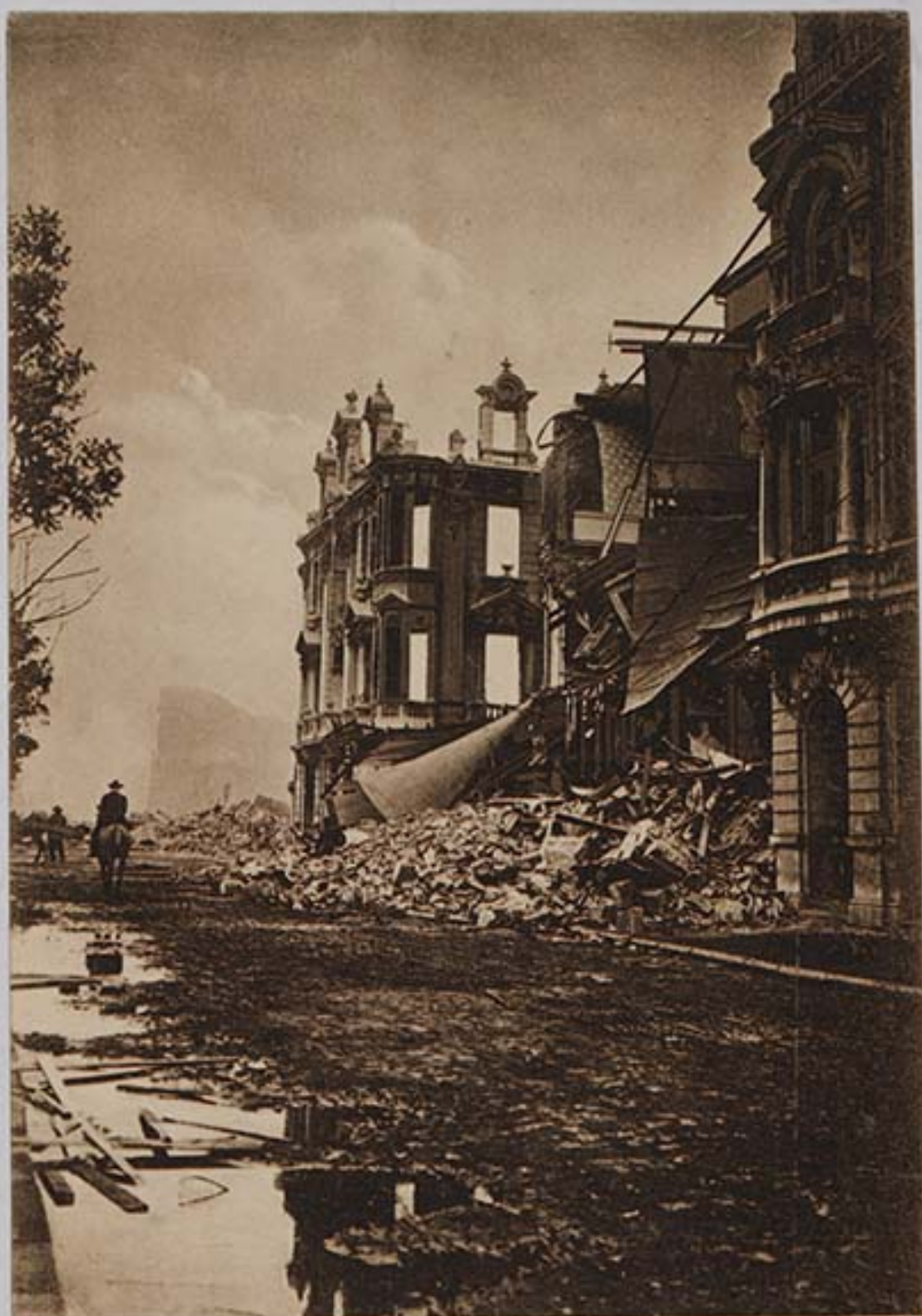
Valparaíso despues del Terremoto Edificio en la Avenida Brasil
