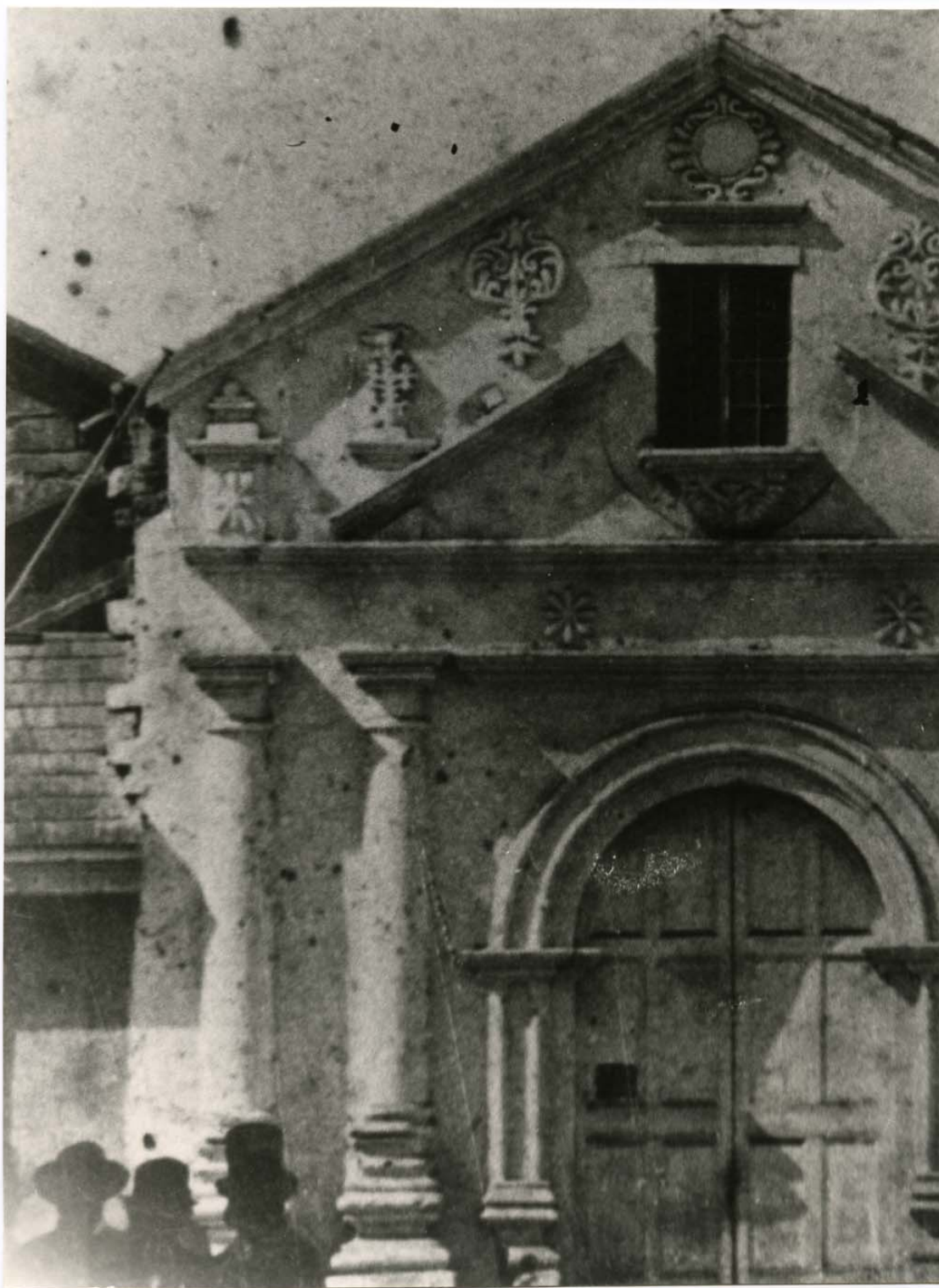
Parte de la fachada de La Iglesia de San Agustín de La Serena
