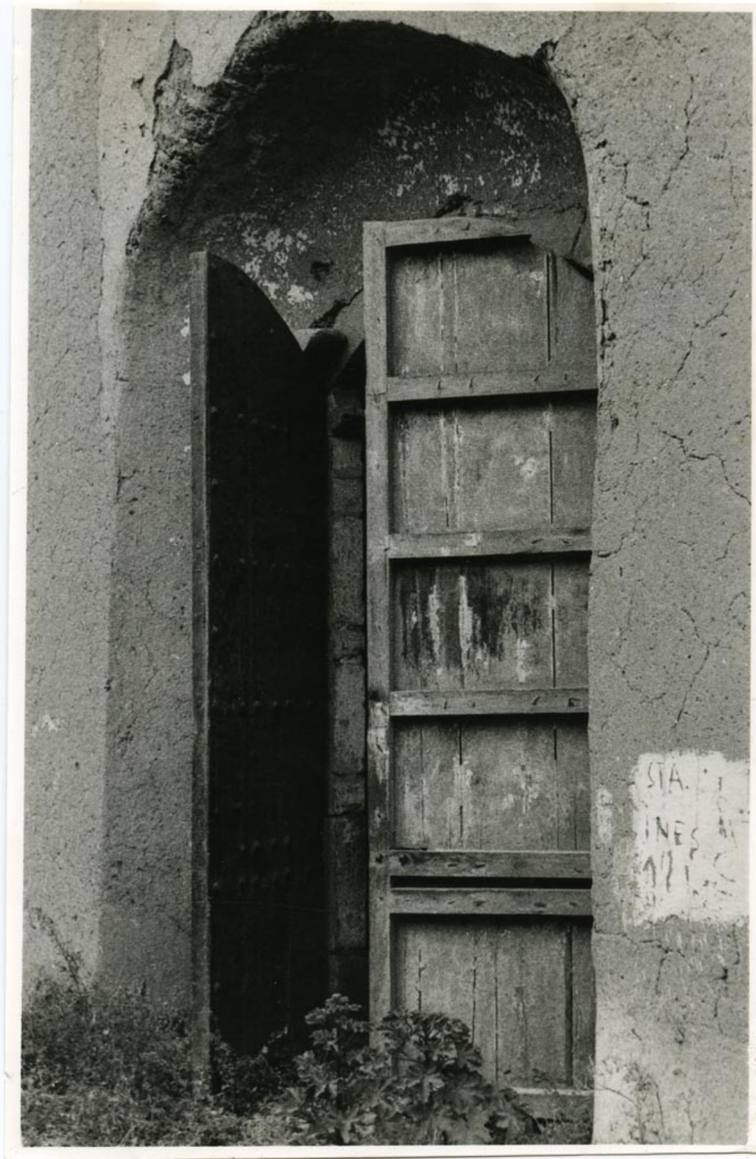
Detalle de puerta de la iglesia Santa Inés de La Serena
