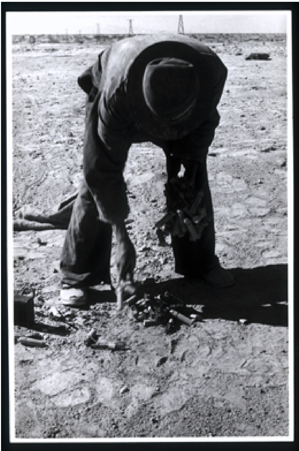
Calichero preparando un explosivo
