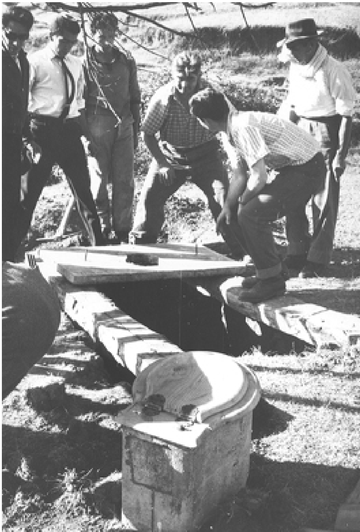
Letrina, Campamento Minero, Trabajos de Verano
