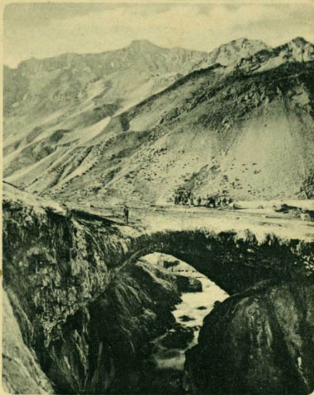
Puente del Inca en la Cordillera 20
