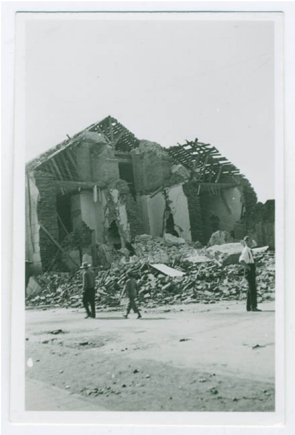
CHILLAN, TERREMOTO - ENTIERRO
