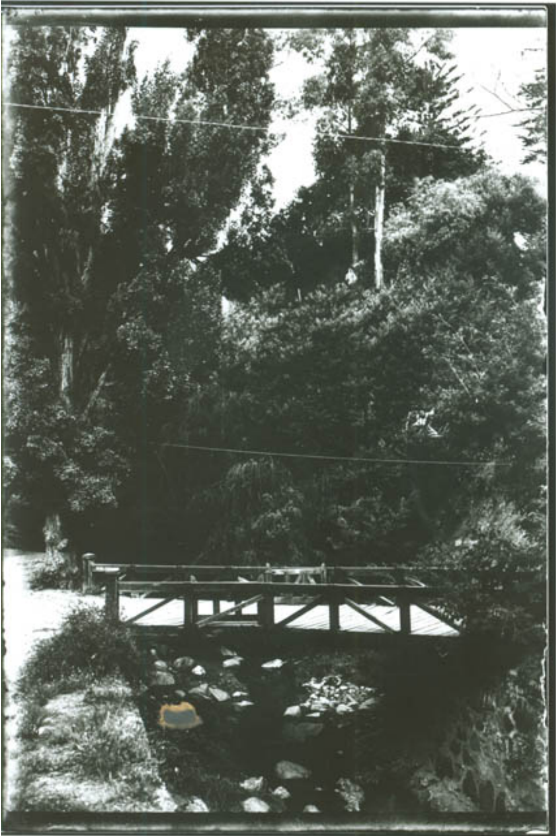
ARBOLEDA CON PUENTE.FOT.ALTSCHWAGER
