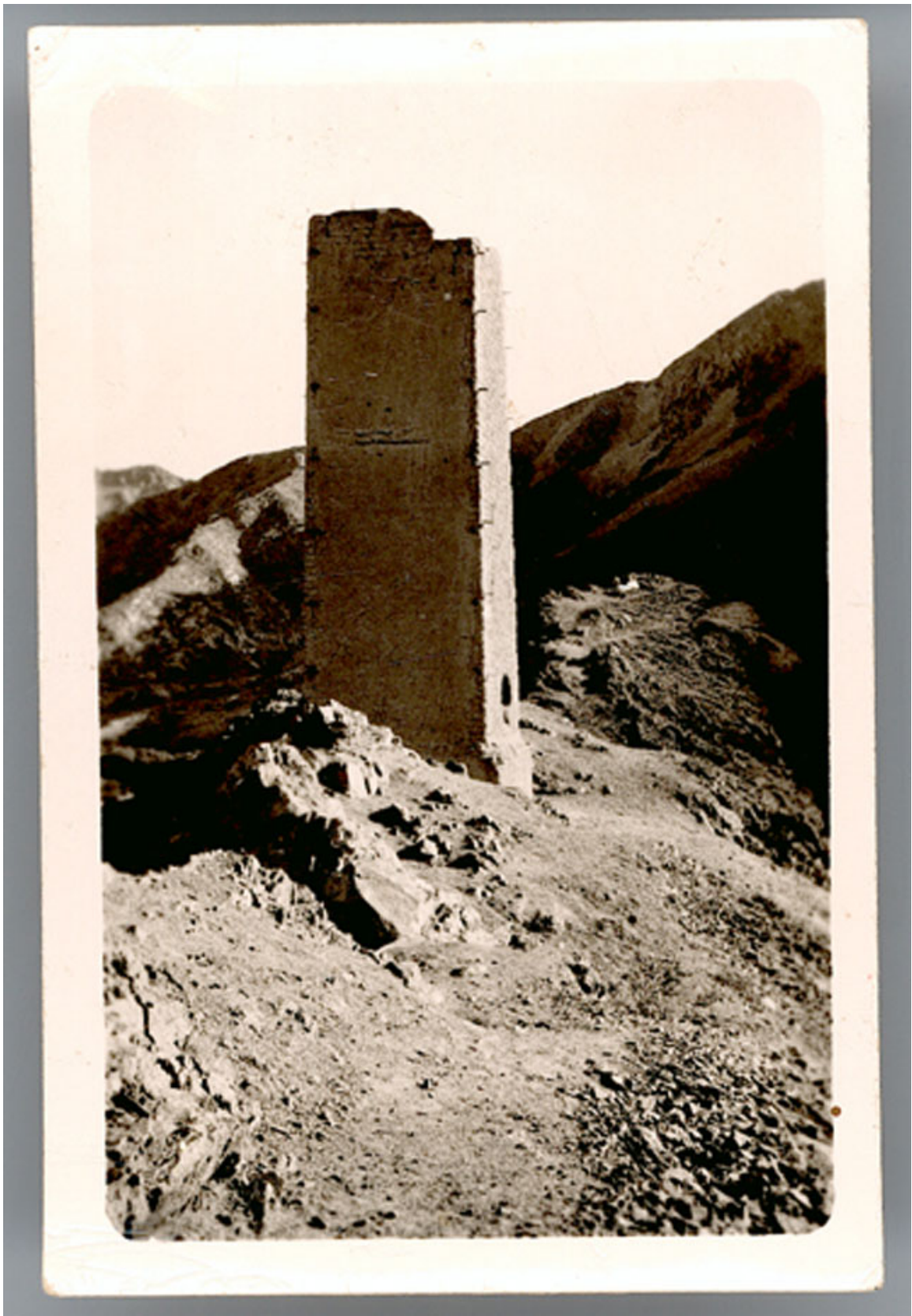
Chimenea en ruinas
