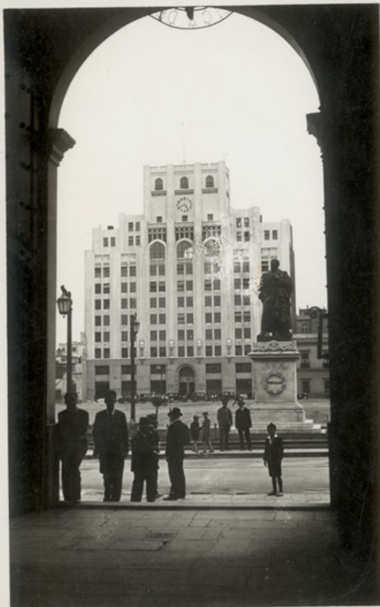
Santiago, Edificio "La Nación"
