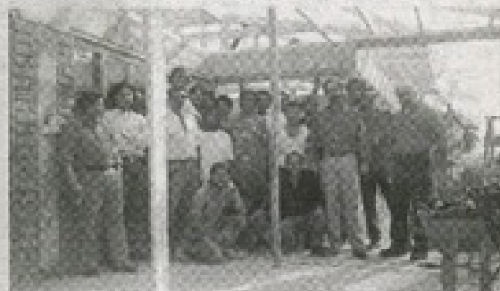
Los cuarenta limachinos que trabajan en la construcción del primer centro comercial y profesional de Limache, celebraron el «Día del Trabajador» y la finalización de la primera etapa de esta importante obra.
