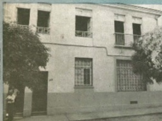
Romero 2421. Se necesitaba una casa grande para albergar una sala de teatro, una de exposiciones y un Centro de Expresión Teatral.
