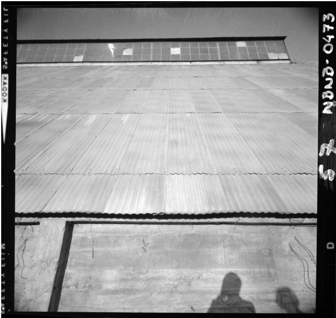
[Vista de techo formado por planchas de zinc acanaladas] [fotografía] Antonio Quintana.
