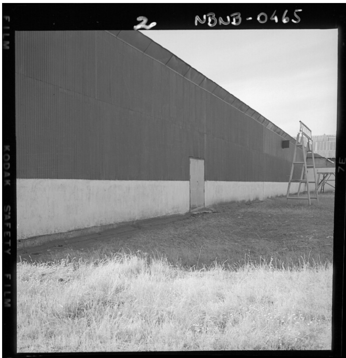
[Vista exterior de pared de fábrica] [fotografía] Antonio Quintana.
