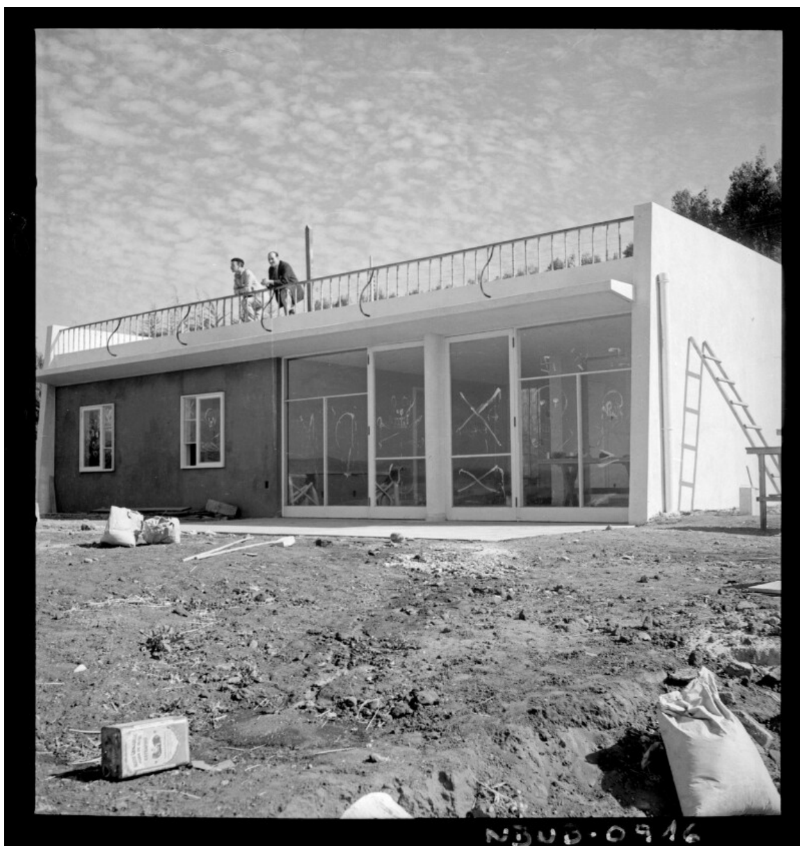
[Primer piso de una vivienda en construcción] [fotografía] Antonio Quintana.
