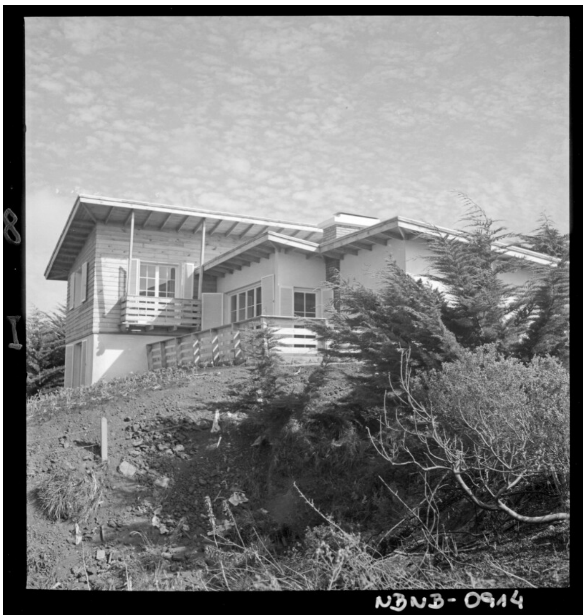
[Vista externa de vivienda] [fotografía] Antonio Quintana.
