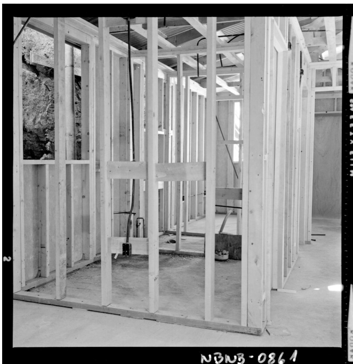
[Estructura de madera] [fotografía] Antonio Quintana.
