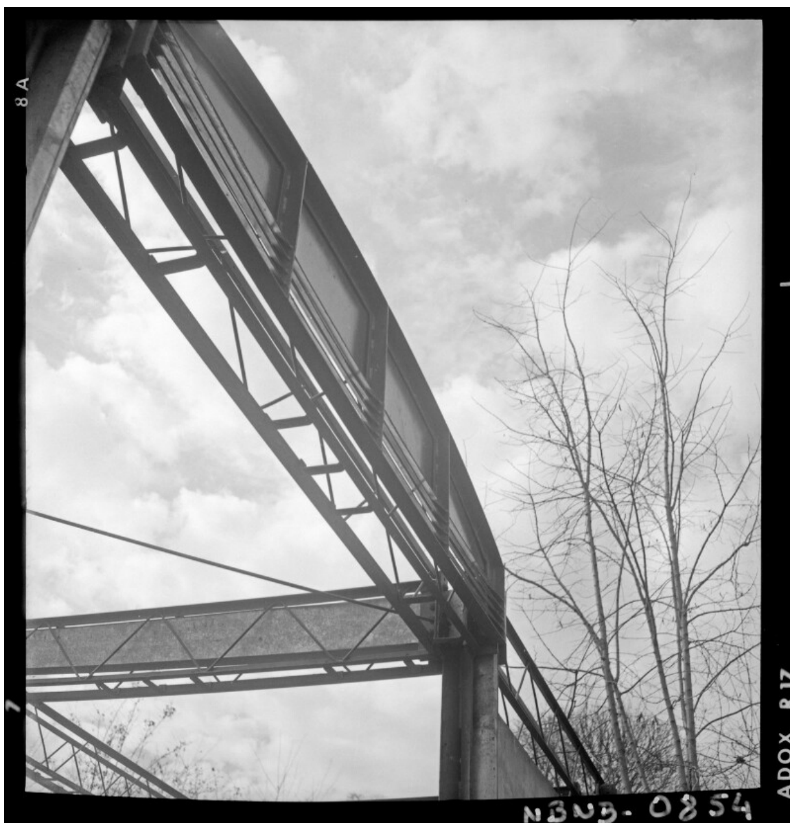
[Estructura metálica] [fotografía] Antonio Quintana.
