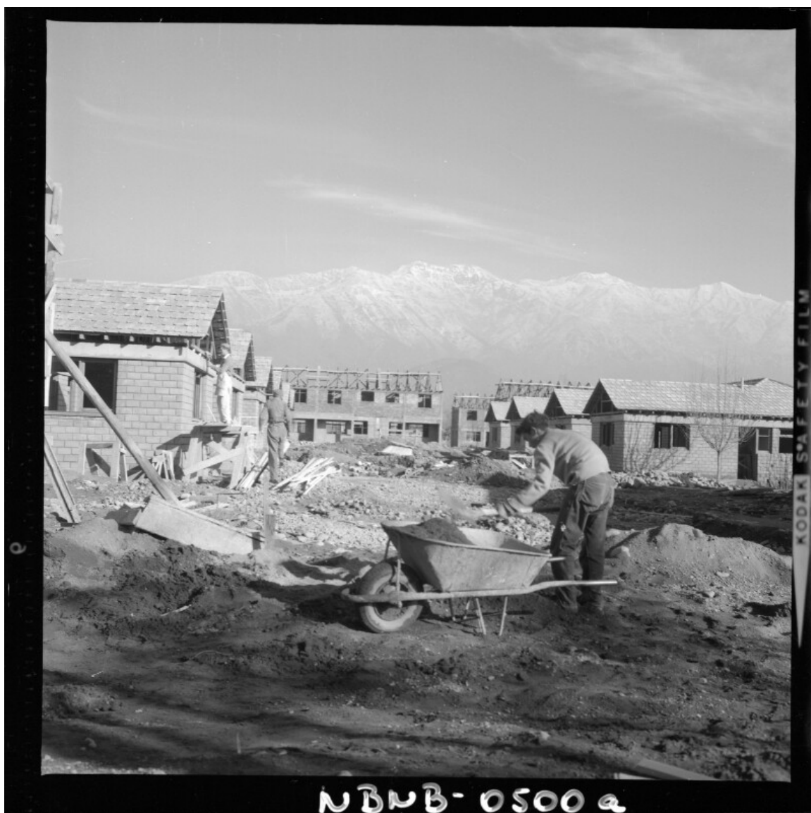
[Hombre trabajando en construcción de viviendas] [fotografía] Antonio Quintana.
