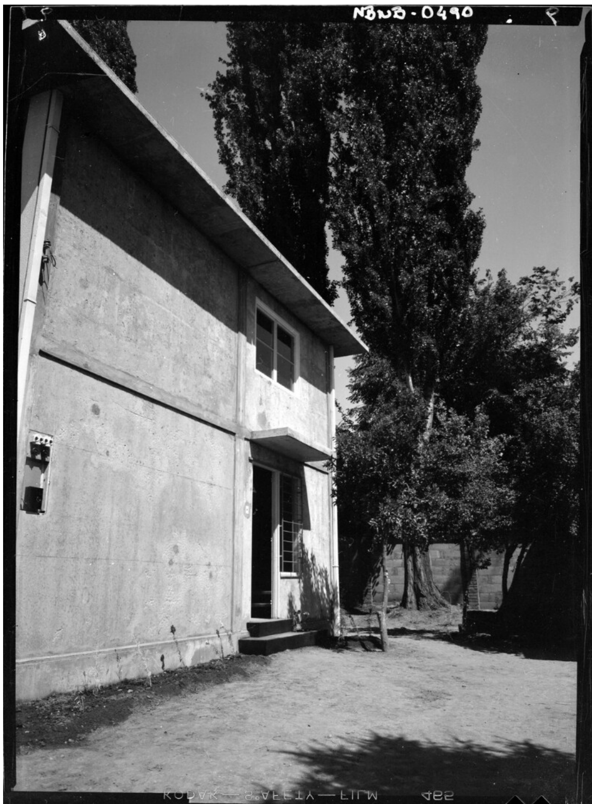
[Exterior de vivienda] [fotografía] Antonio Quintana.
