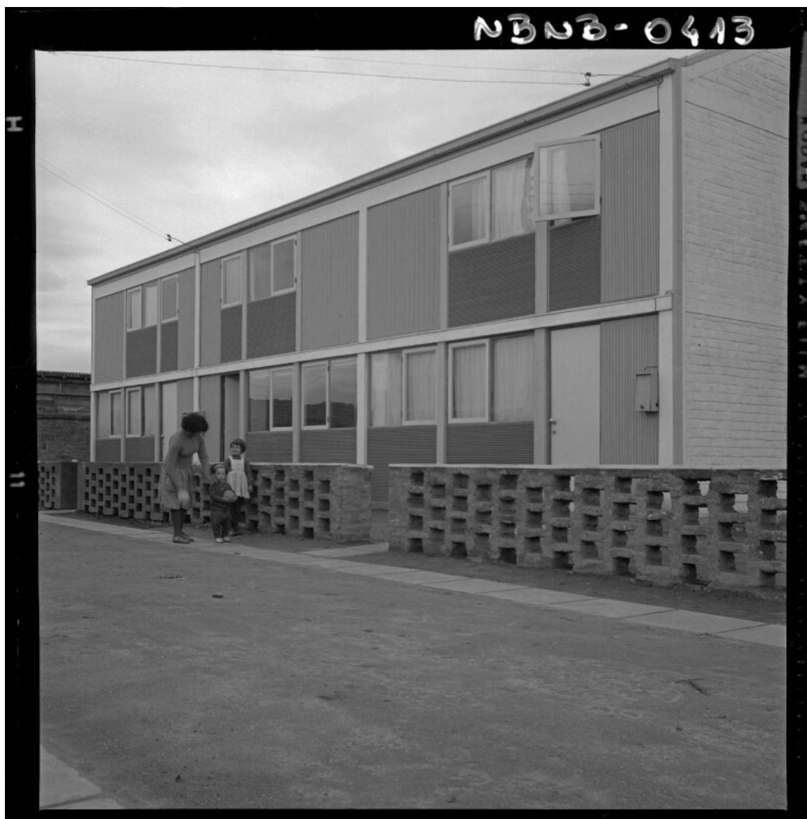
[Conjunto de viviendas] [fotografía] Antonio Quintana.
