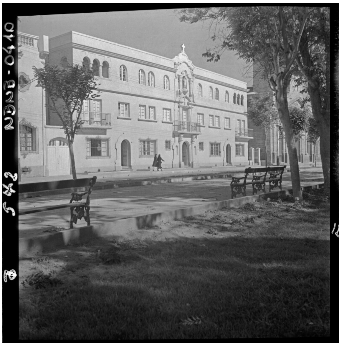
[Frontis de edificio] [fotografía] Antonio Quintana.
