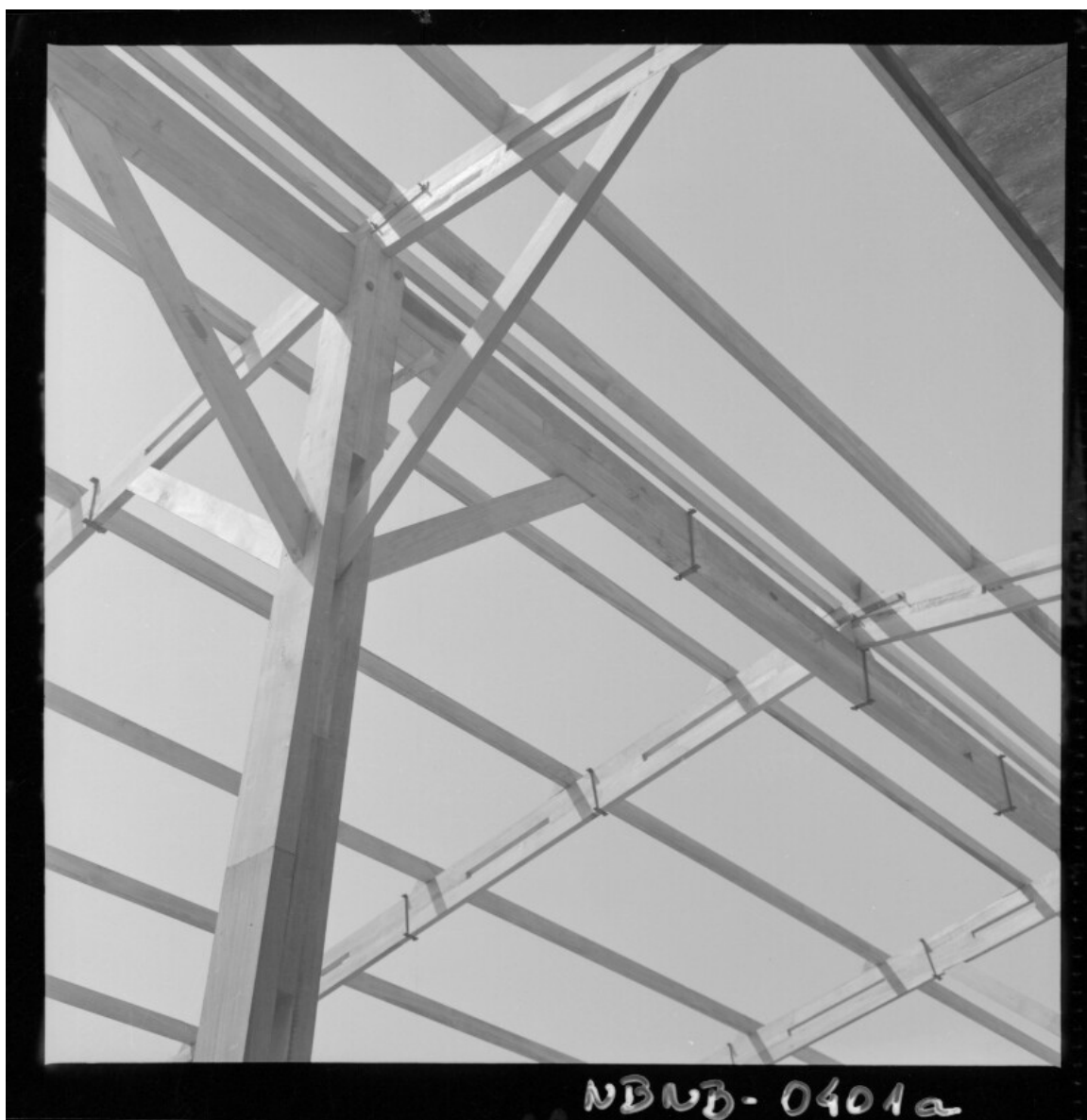
[Estructura metálica] [fotografía] Antonio Quintana.
