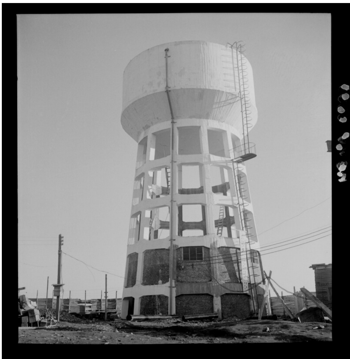
[Tanque elevado de agua] [fotografía] Antonio Quintana.
