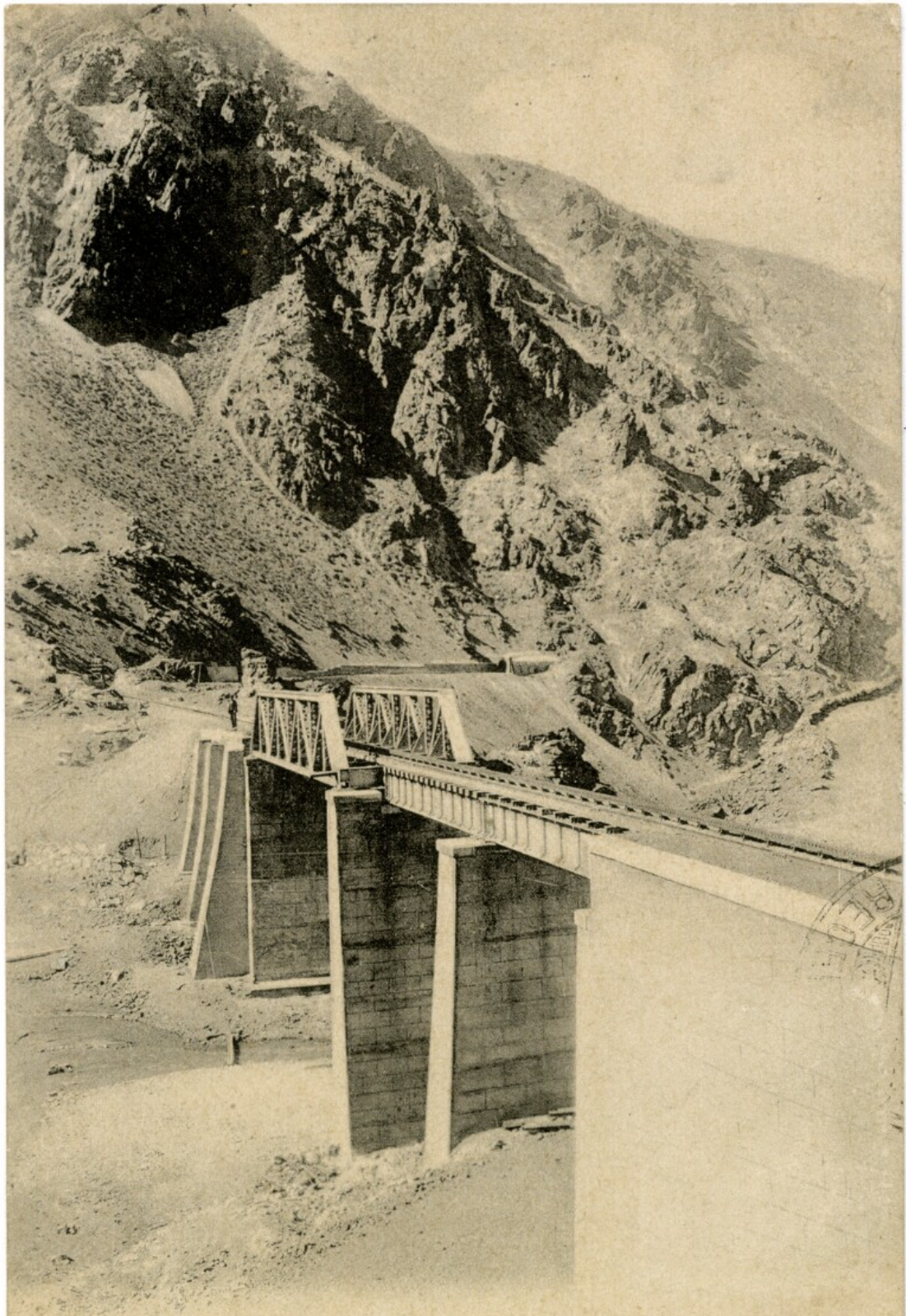
Puente llagando al Portillo. Ferro-carril. Trasandino.
