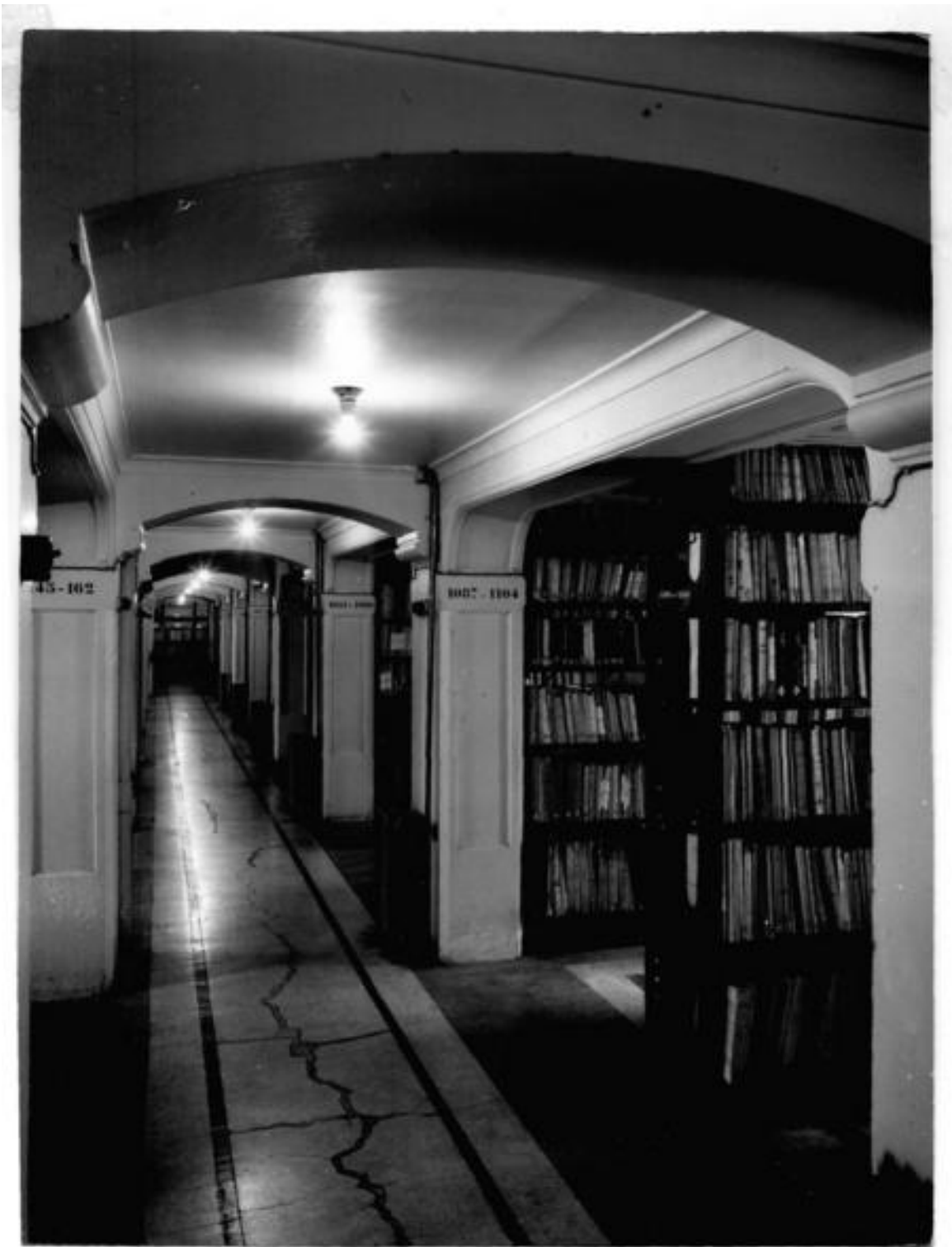
[Biblioteca Nacional. Estanterías de depósito] [fotografía].
