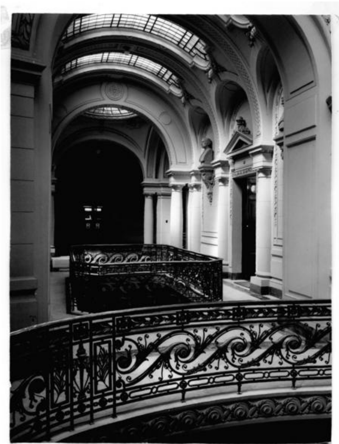
[Biblioteca Nacional. Rotonda y cúpula del segundo piso] [fotografía].
