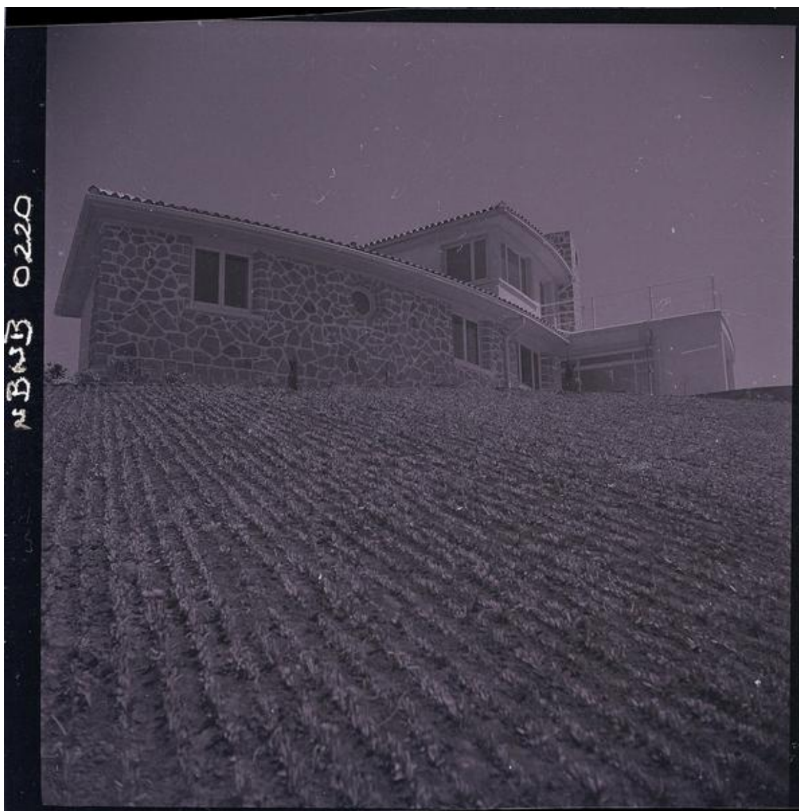
Casona de piedra a la vista [fotografía] Ignacio Hochhäusler.
