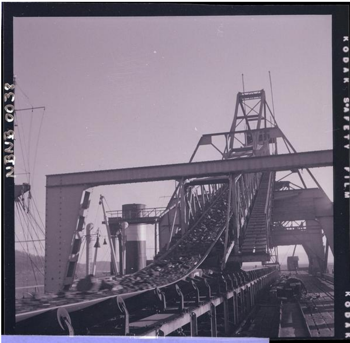
[Carbón conducido por la cinta transportadora hasta el cargador móvil, instalado en el muelle de embarque] [fotografía] Ignacio Hochhäusler.
