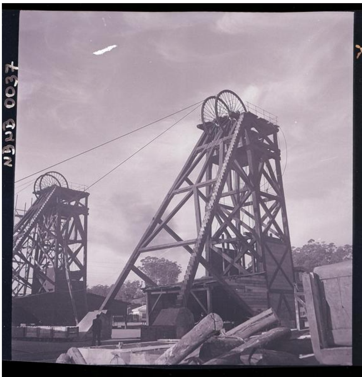
[Torres de extracción; exterior de la mina de carbón de Lota] [fotografía] Ignacio Hochhäusler.
