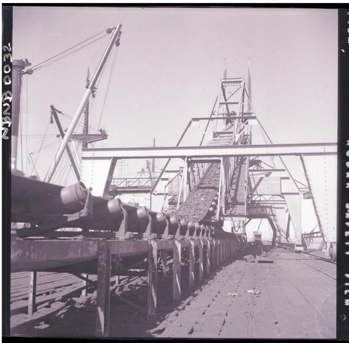
[Carbón conducido por la cinta transportadora hasta el cargador móvil, instalado en el muelle de embarque; mina de carbón de Lota] [fotografía] Ignacio Hochhäusler.
