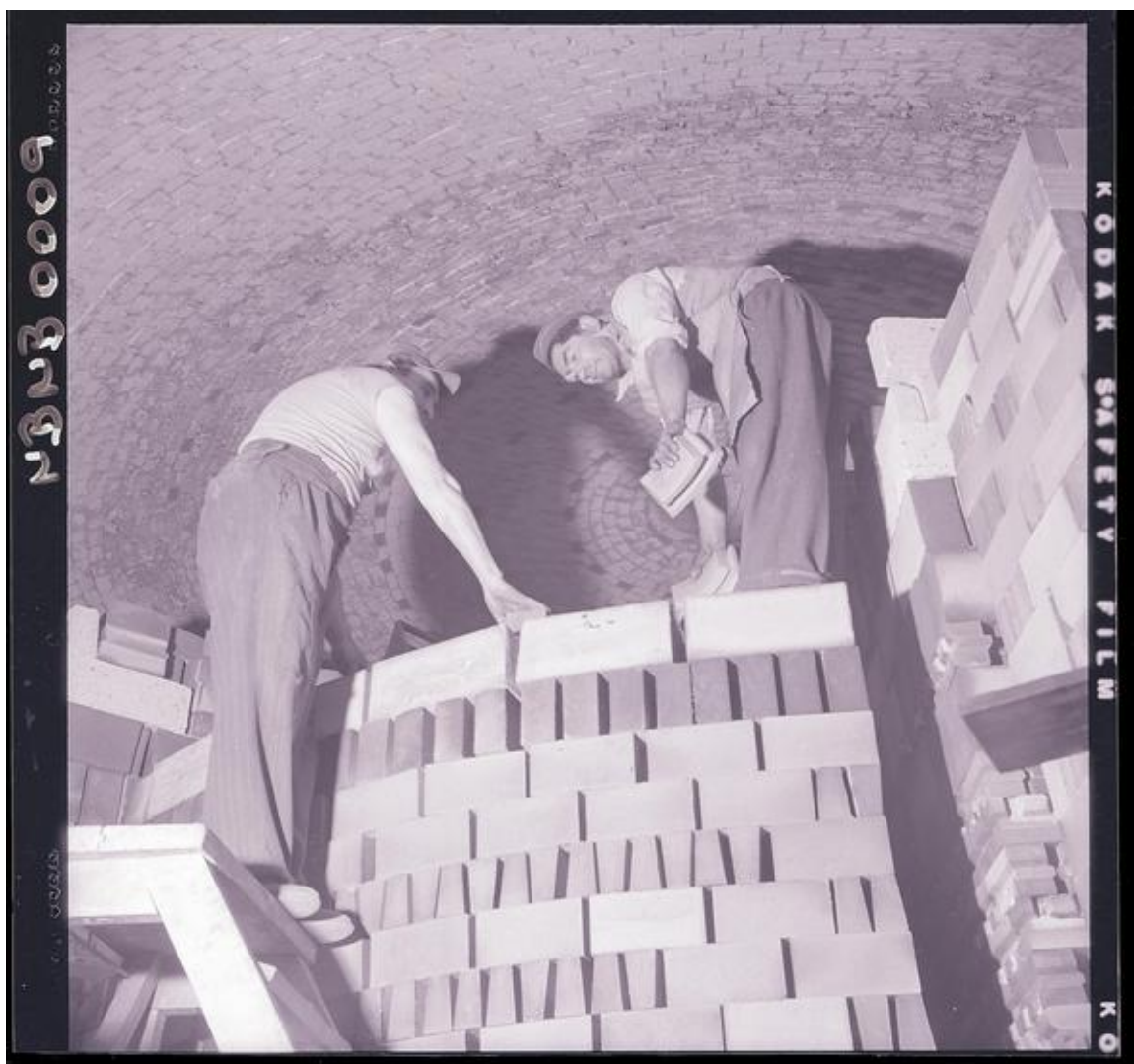
[Producción de ladrillos refractarios; Lota] [fotografía] Ignacio Hochhäusler.
