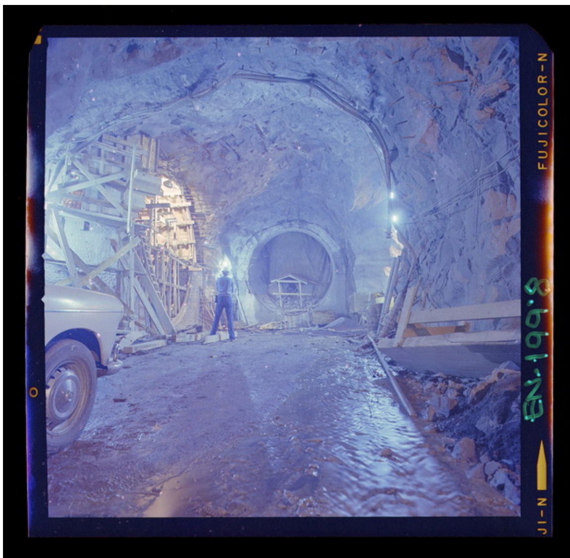
Bifurcación de los túneles que caen sobre la caja de máquinas (pantalón) [fotografía] Luis Ladrón de Guevara.
