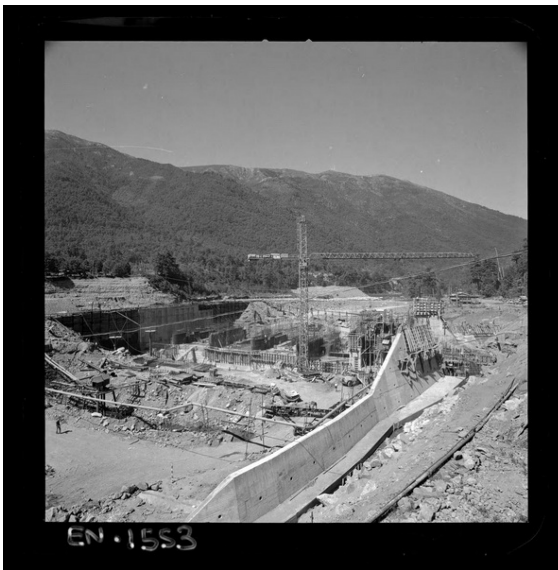
[Río Polcura; obras de construcción de la bocatoma Polcura, última etapa] [fotografía] Luis Ladrón de Guevara.
