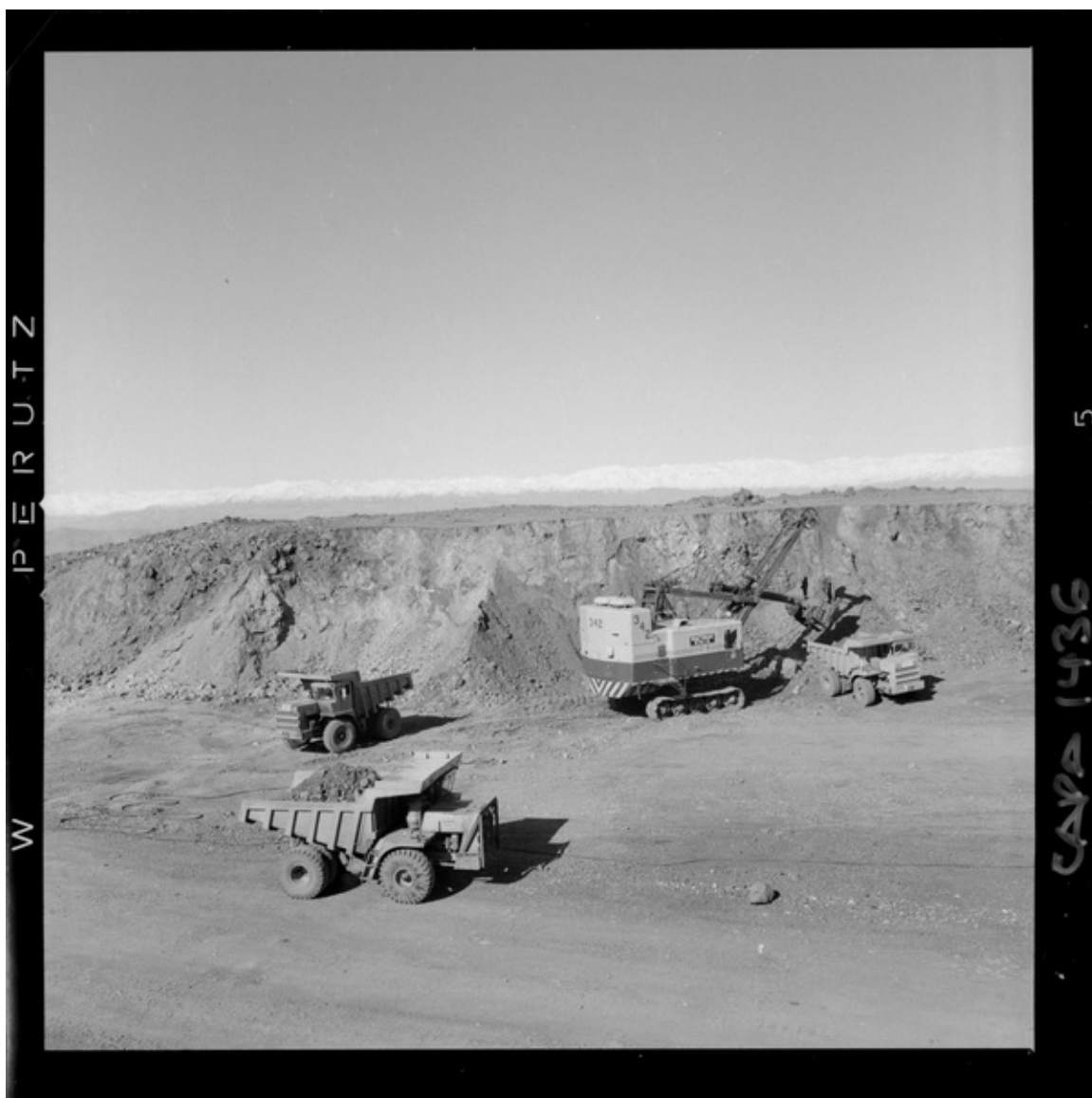
[Excavadora "Bucyrus Eire" modelo 110 B y otros equipos, exterior mina "El Algarrobo"] [fotografía] Luis Ladrón de Guevara.
