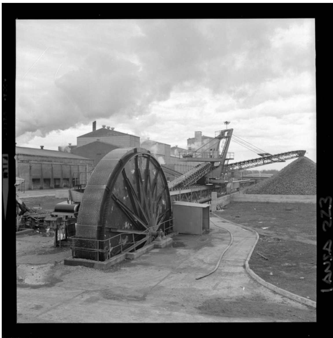
[Iansa (Chile) : Planta Cocharcas : Descarga por medio mecánico en silos] [fotografía] Luis Ladrón de Guevara.
