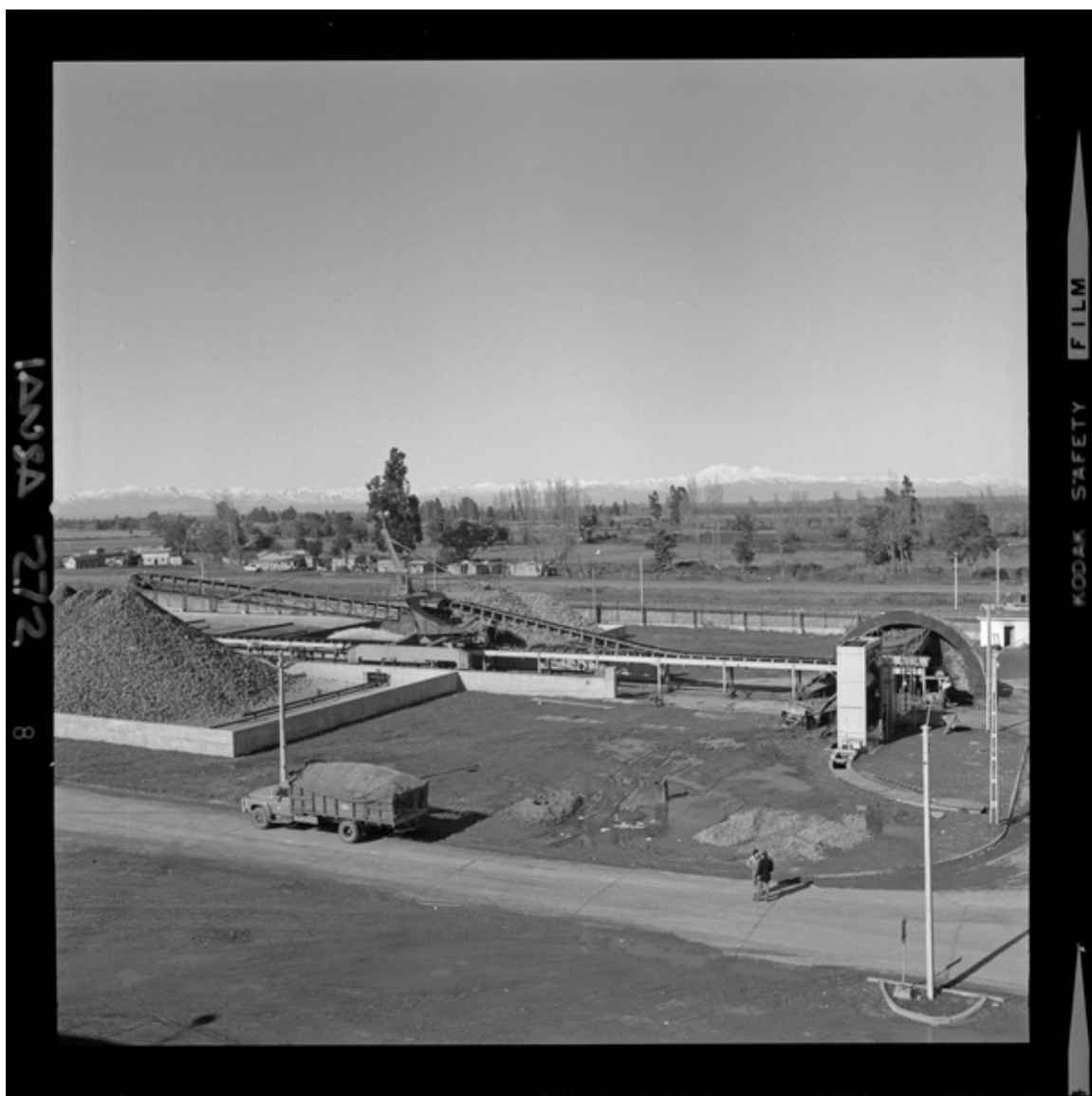
[Iansa (Chile) : Planta Cocharcas : Fase del proceso de la remolacha para convertirse en azúcar] [fotografía] Luis Ladrón de Guevara.
