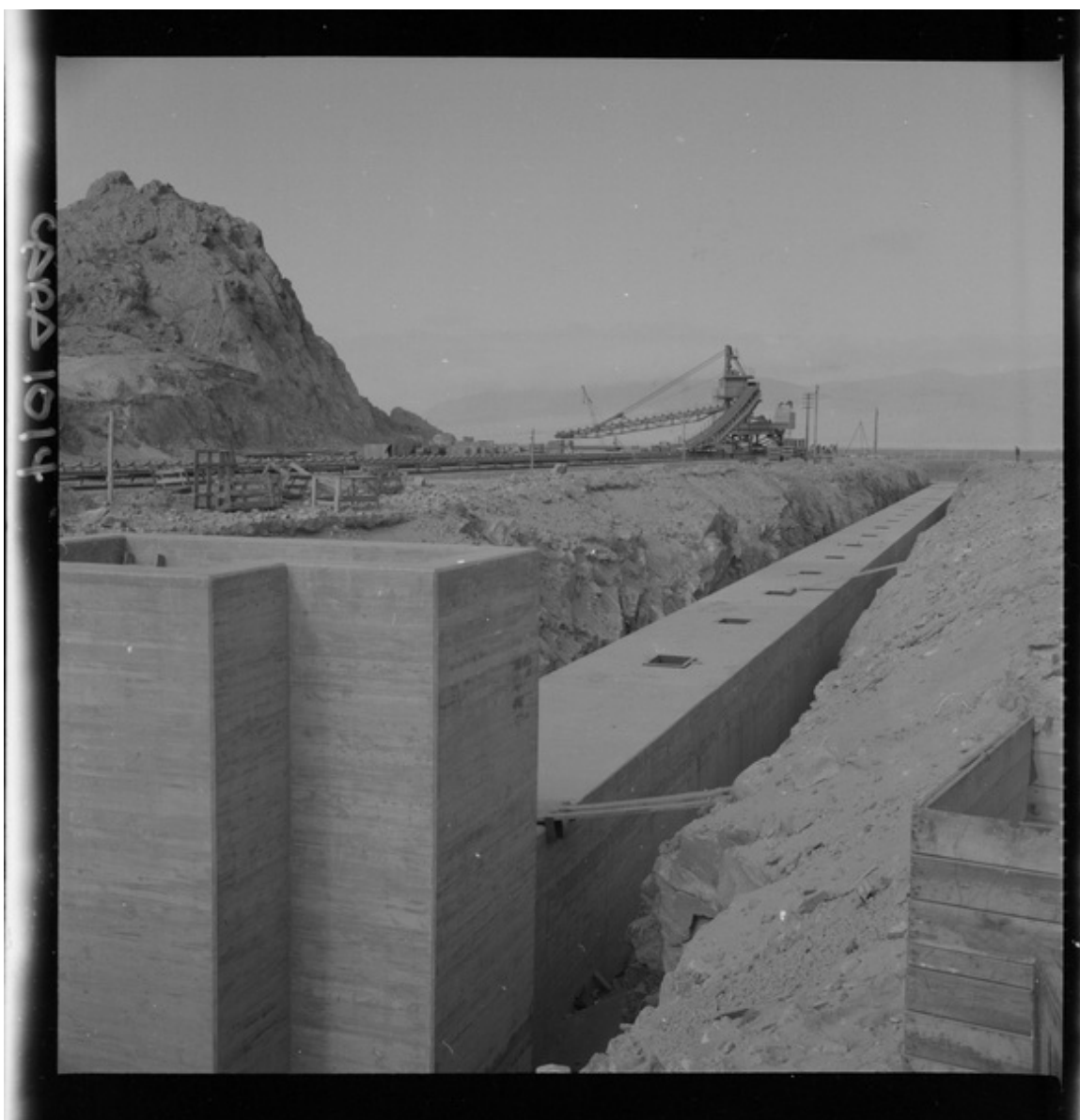
[Puerto de embarque; faja transportadora de minerales y contenedores a tajo abierto; yacimiento "El Algarrobo"]
