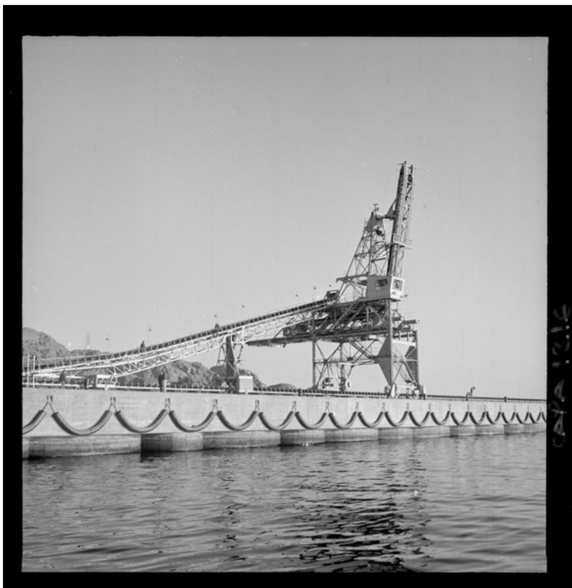
[Puerto de embarque; faja transportadora de minerales, yacimiento "El Algarrobo"] [fotografía] Luis Ladrón de Guevara.
