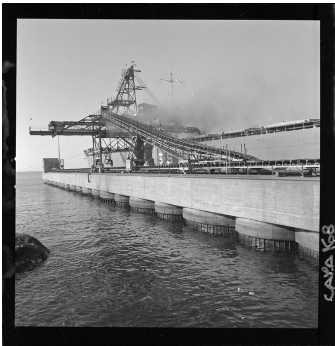
[Puerto de embarque; cargadero, minerales del yacimiento "El Algarrobo"] [fotografía] Luis Ladrón de Guevara.
