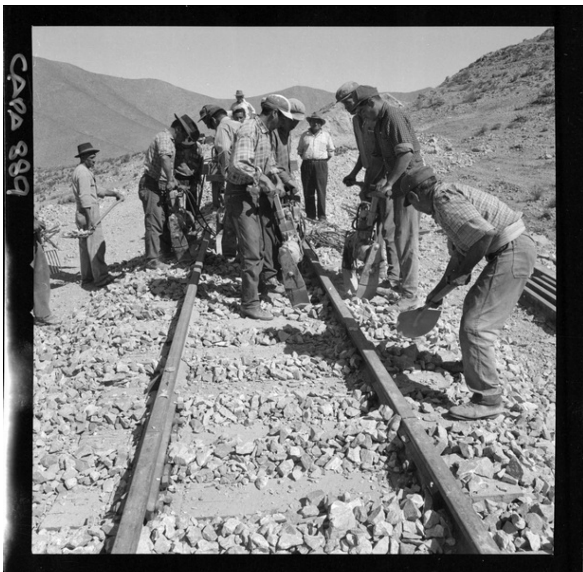
[Trabajos en la línea férrea, transporta el mineral de hierro de "El Algarrobo" hasta el puerto de Huasco] [fotografía] Luis Ladrón de Guevara.
