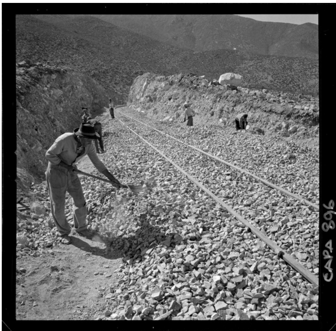
[Trabajos en la línea férrea que transporta el hierro de "El Algarrobo" hasta el puerto de Huasco] [fotografía] Luis Ladrón de Guevara.
