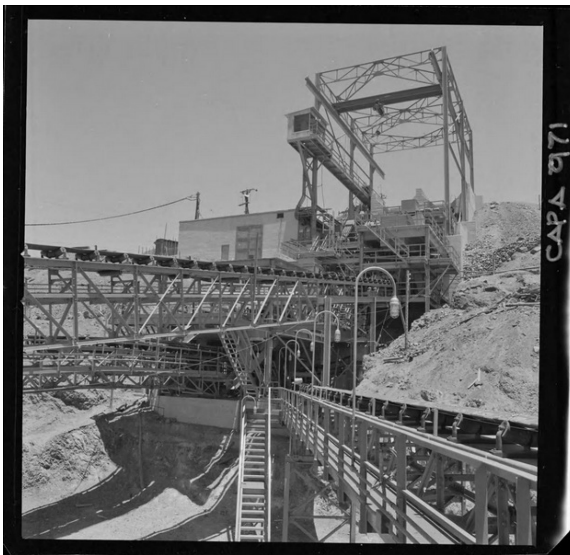
[Obras de construcción, mina "El Algarrobo"] [fotografía] Luis Ladrón de Guevara.
