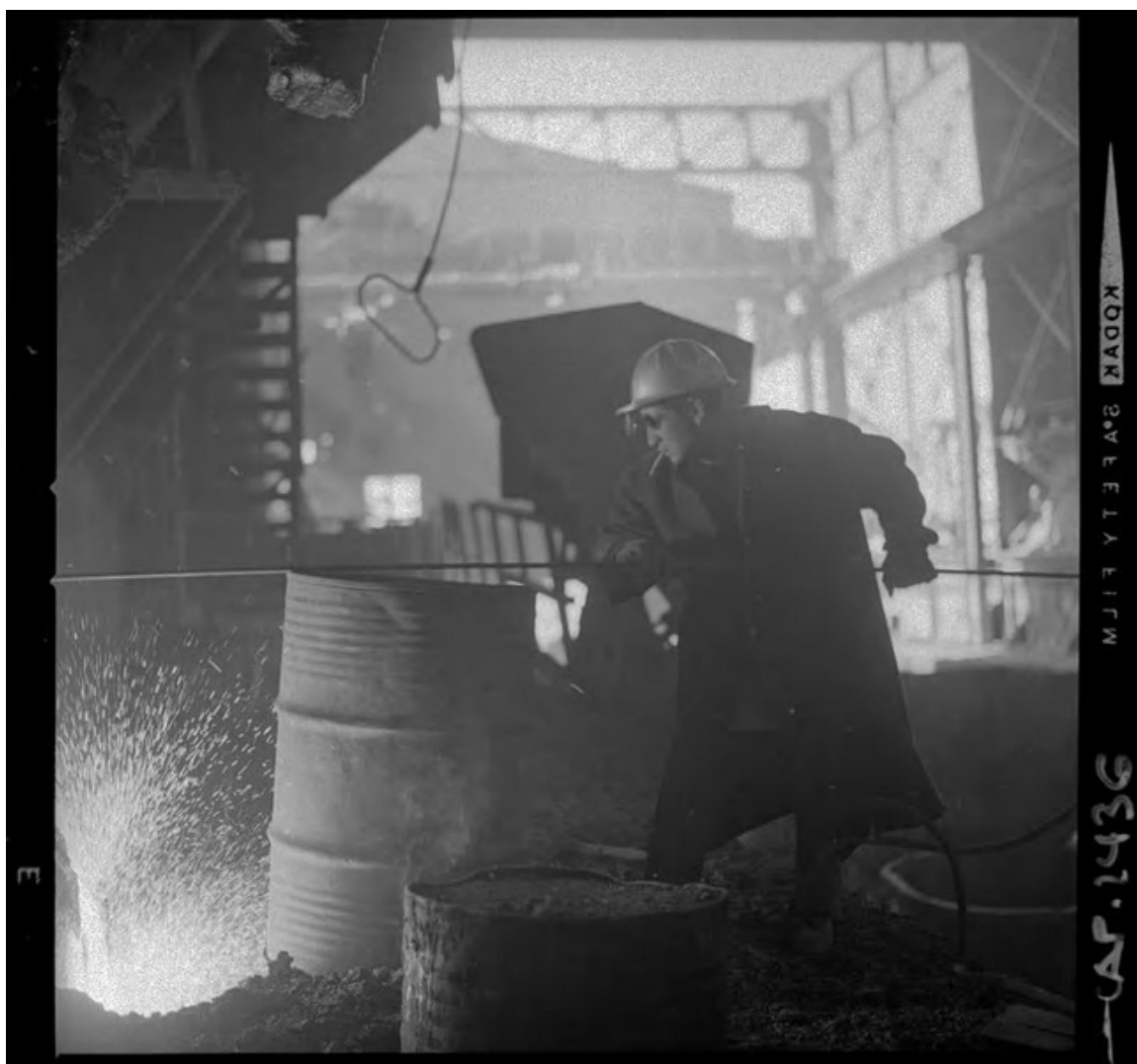
[Compañía de Acero del Pacífico : Alto Horno, fundición de acero Huachipato] [fotografía] Luis Ladrón de Guevara.
