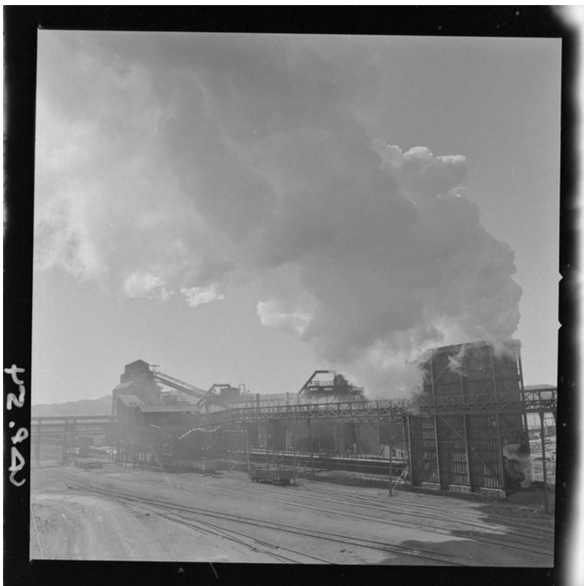
[Compañía de Acero del Pacífico : Coquería Huachipato] [fotografía] Luis Ladrón de Guevara.
