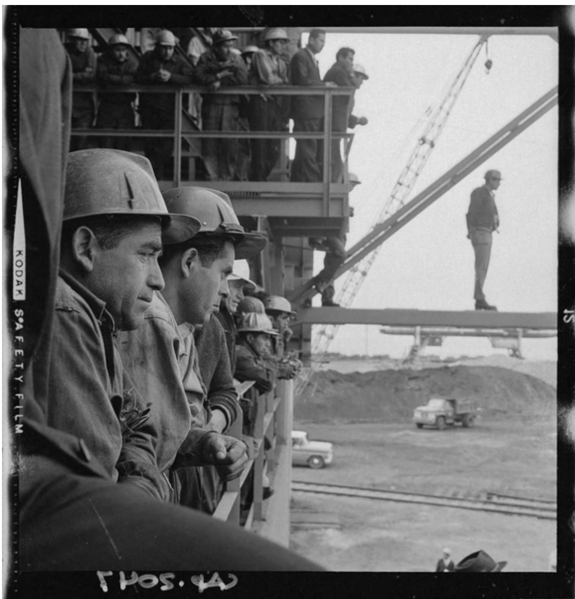
[Compañía de Acero del Pacífico : Planta Siderúrgica de Huachipato] [fotografía] Luis Ladrón de Guevara.
