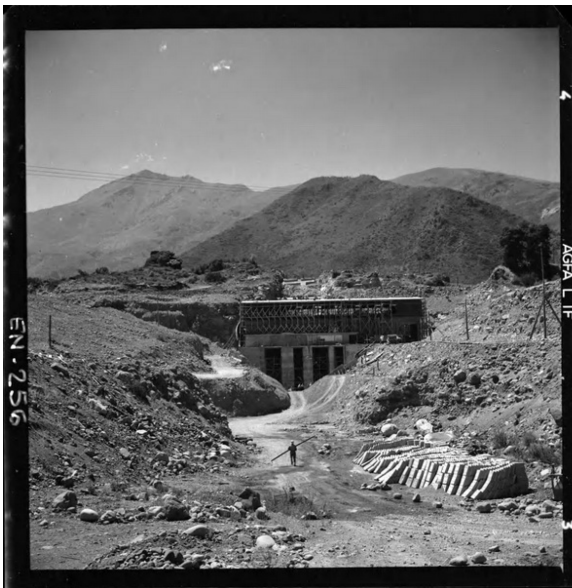
[Construcción casa de máquinas] [fotografía] Luis Ladrón de Guevara.
