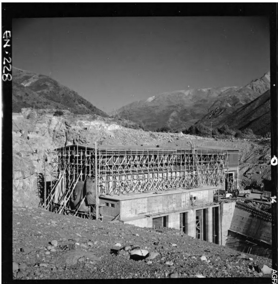
[Construcción casa de máquinas] [fotografía] Luis Ladrón de Guevara.
