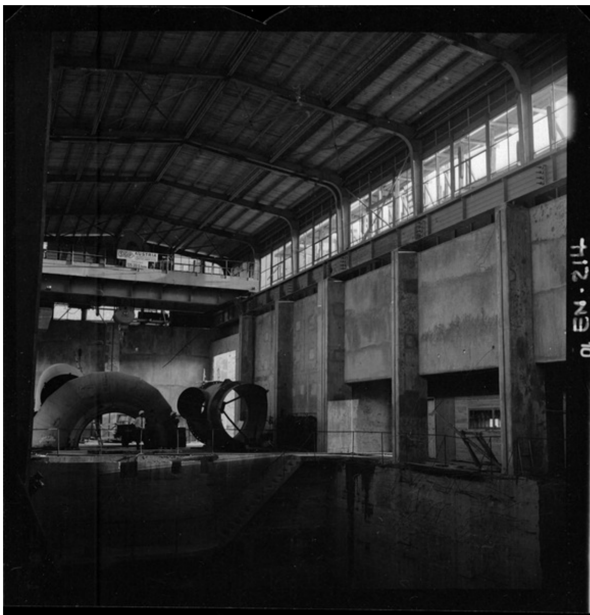
[Vista interior; construcción de la casa de máquinas] [fotografía] Luis Ladrón de Guevara.
