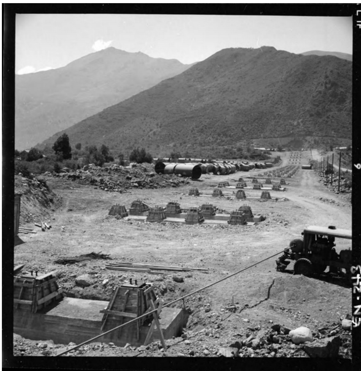
[Fundaciones para dos tuberías de acero, fabricadas por la Compañía de Acero del Pacífico, esperando su instalación] [fotografía] Luis Ladrón de Guevara.
